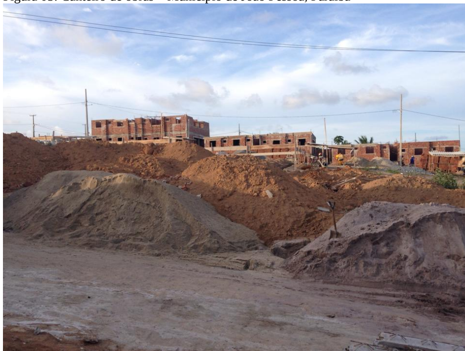
Figura 03: Canteiro de obras – Município de João Pessoa, Paraíba
