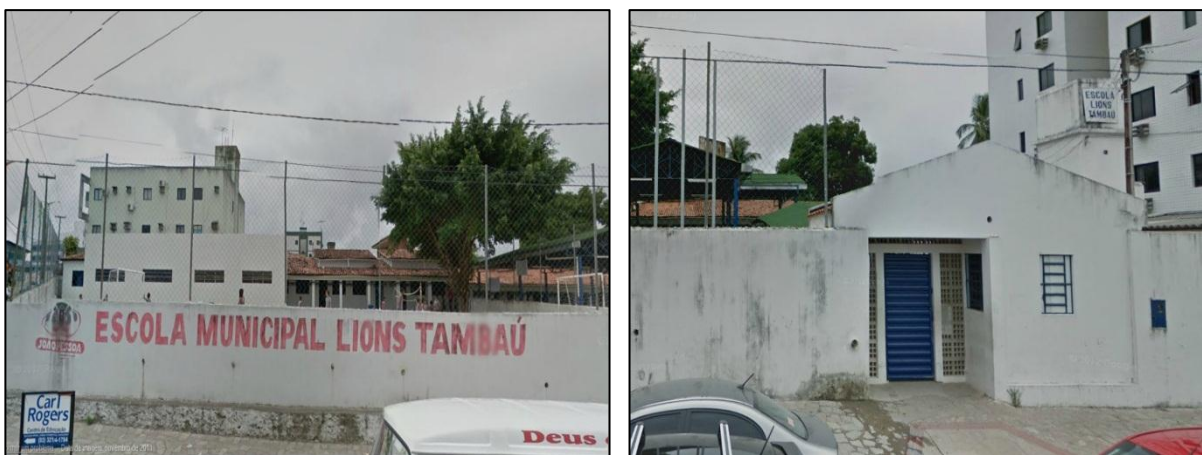
Figura 3 - Fachada da EMEF Lions Tambaú (esquerda) e única entrada da escola (direita).
