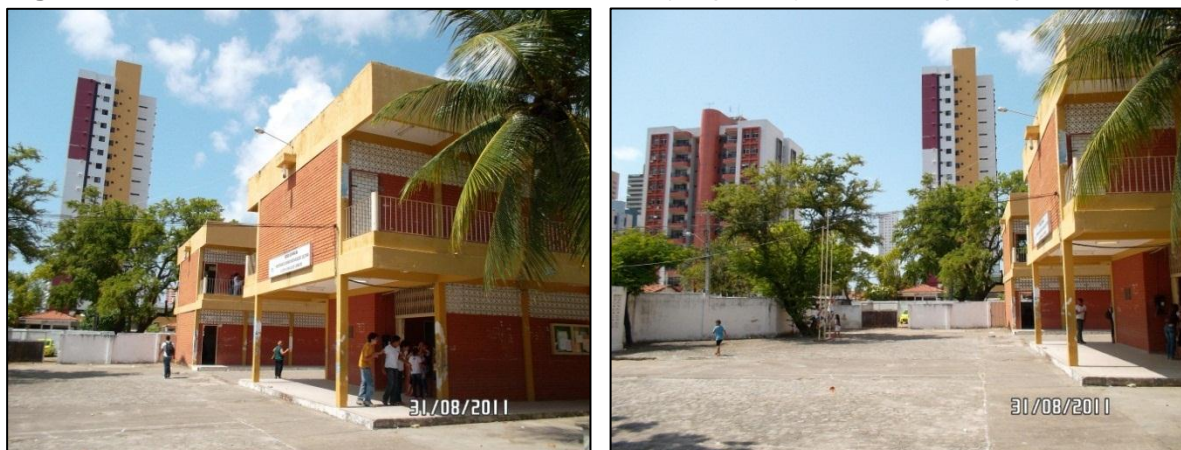
Figura 5. EEEFM - Alice Carneiro. Bloco de salas (esquerda) e entrada principal da escola
