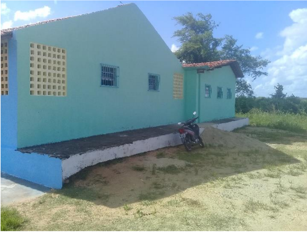
Vista Lateral da escola
