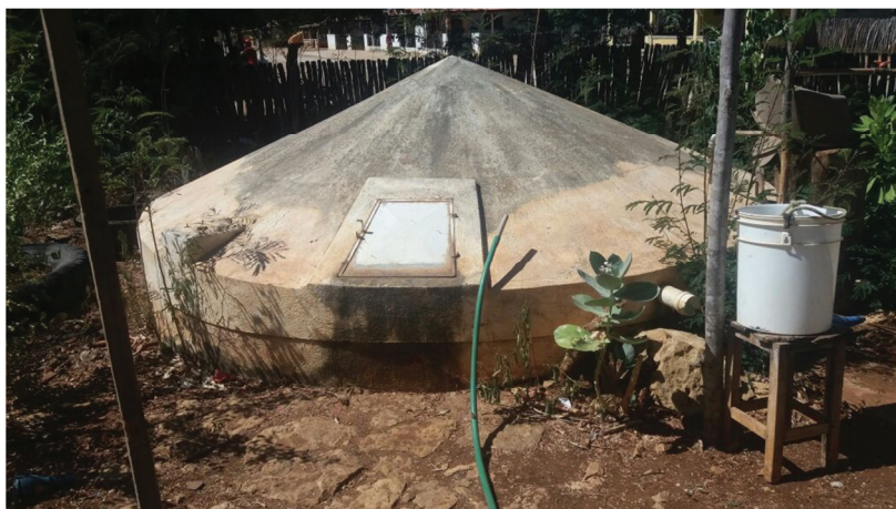
Figura 9 – Cisterna de placa no assentamento Sítio do Góis
