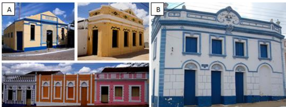
Figura 05 – (A) Casarios do patrimônio histórico-arquitetônico do município de São João do Cariri. (B) Vista frontal do Casarão dos Árabes.
