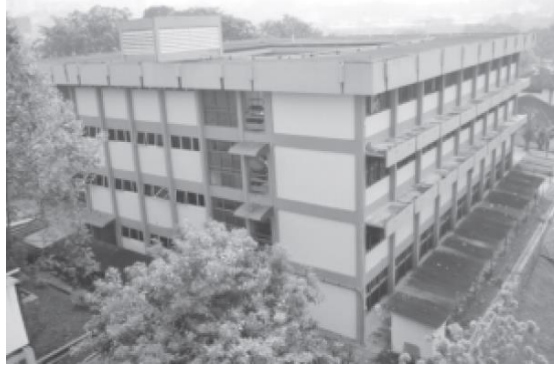
C5 – Daya Sari: fachada de um dos blocos
