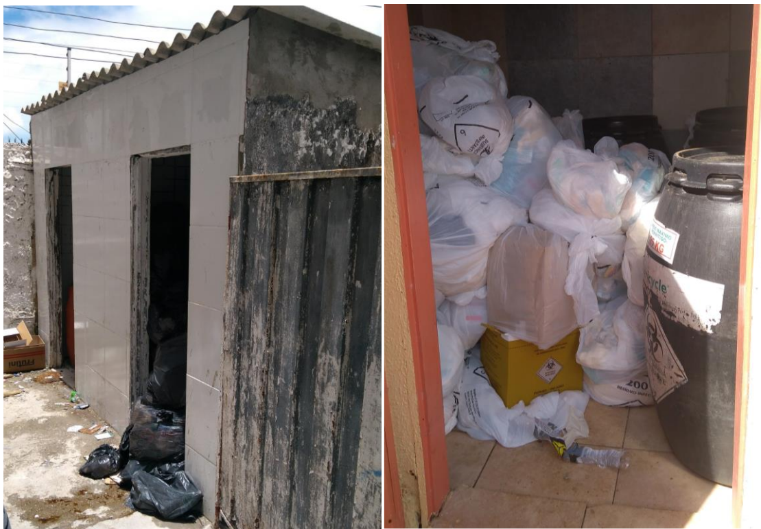
Figura 12 – Abrigos externos de resíduos subdimensionados a) Abrigo externo de resíduos do grupo D (Hospital Q). b) Abrigo externo de resíduos infectantes (Hospital L).
