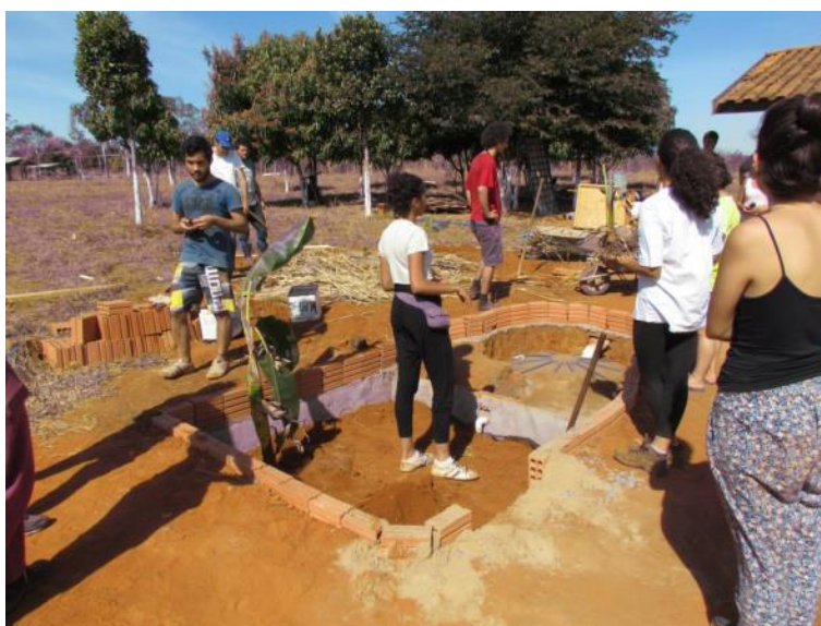
FIGURA15: Mutirão de Construção da Fossa de Evapotranspiração, junho de 2014
