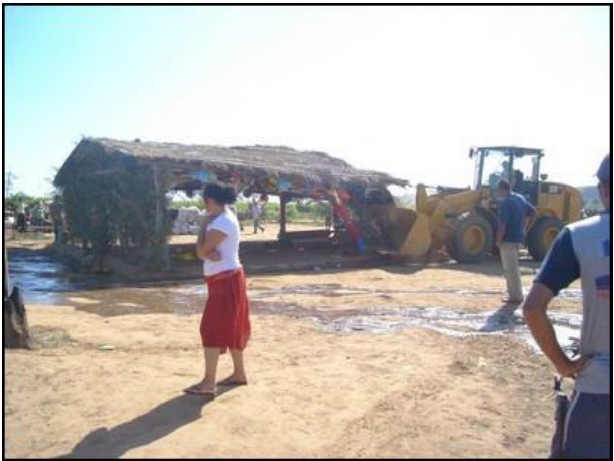
FIGURA 4: Demolição do barracão no dia do despejo no Acampamento Elizabeth Teixeira (fonte: < http://juventudepsol.blogspot.com/2007/11/odia-em-que-morri.html >).
