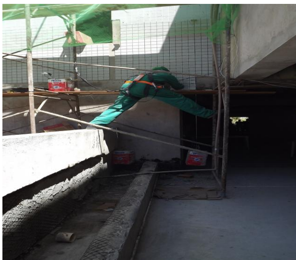
Figura 17 – Tarefa de revestimento em área externa do prédio
