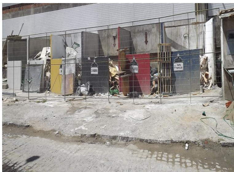
Figura 27 – Local destinado para depósito de RCD por classe
