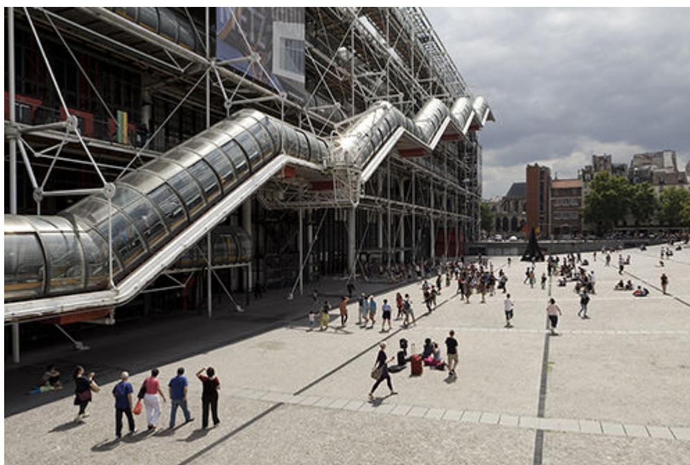
Figura 14: Centro Pompidou. Disponível em: http:// www.centrepompidou.fr
