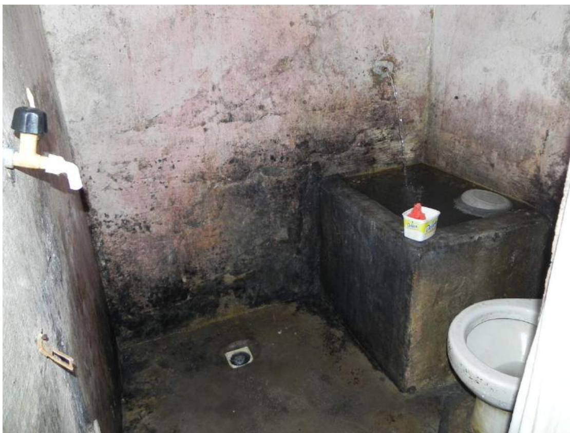
Figura 13 – Banheiro da Ala LGBT
