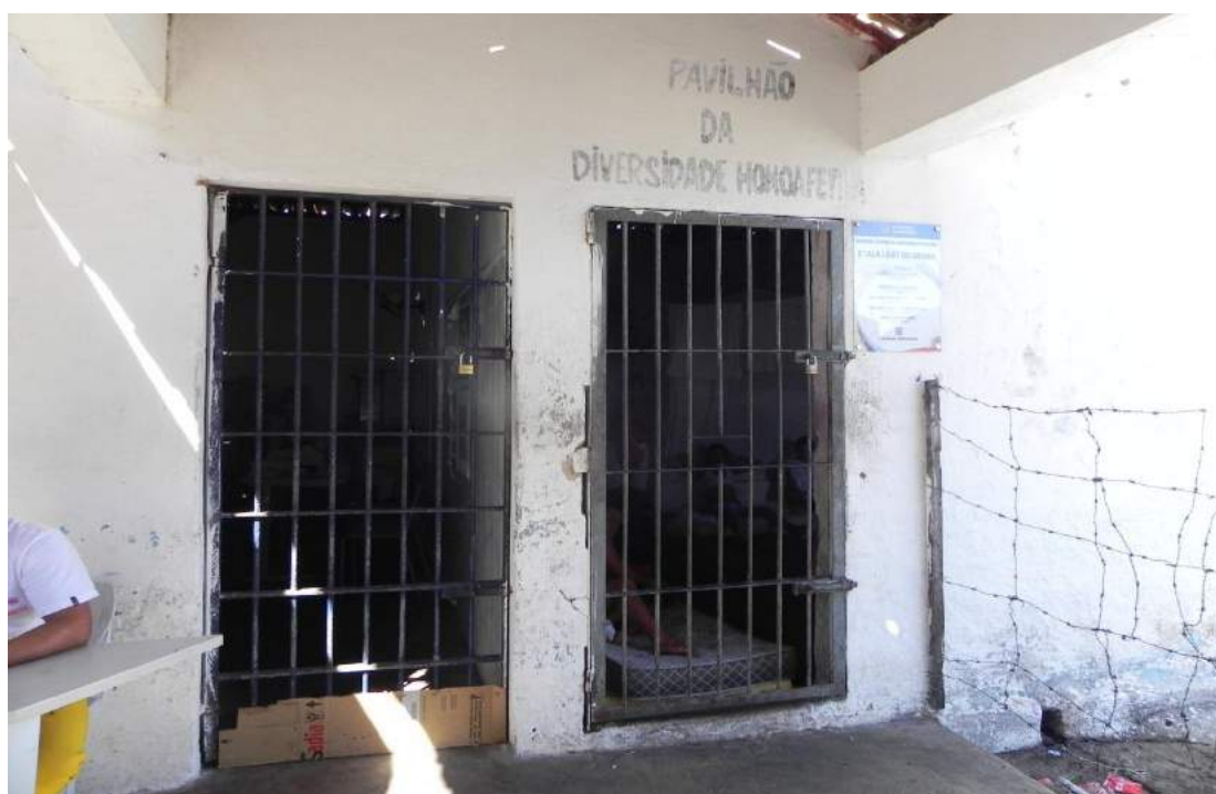
Figura 2 – Pavilhão da Diversidade Homoafetiva, grade do lado direito. À esquerda fica a sala de aula. (Ala LGBT)
