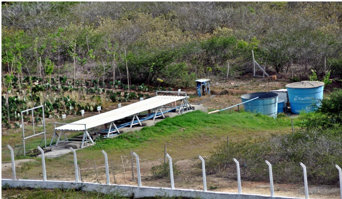
Figura 2 Estação de tratamento primário de esgoto doméstico da sede do Instituto Nacional do Semiárido, Campina Grande, PB.
