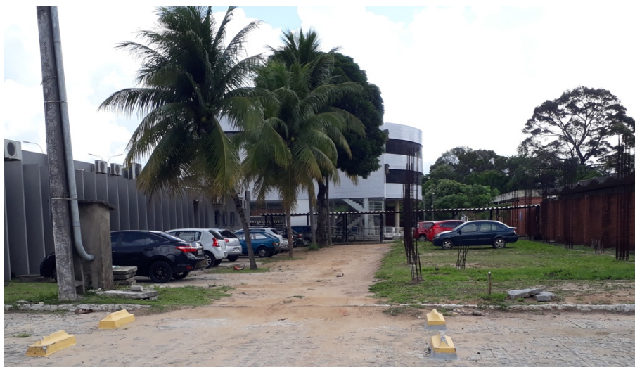
Figura 21 - Carros estacionados em uma obra paralisada no CT.
