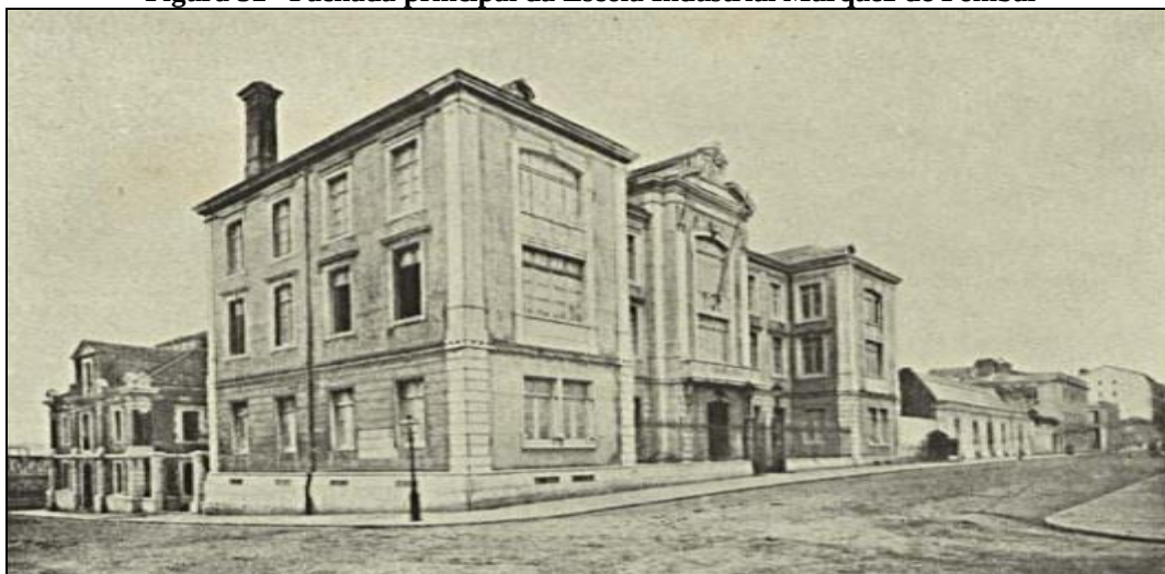
Figura 32– Fachada principal da Escola Industrial Marquez de Pombal
