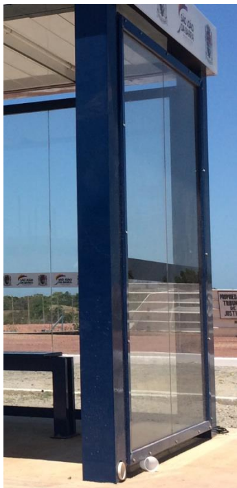
Figura 13: Estrutura de metal e laterais de vidro
