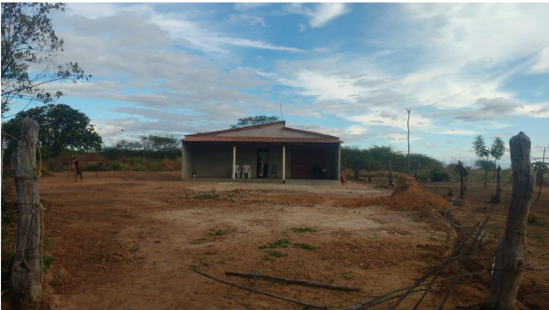
Imagem 8 - Nova casa construída pela empresa Lara para o assentamento
