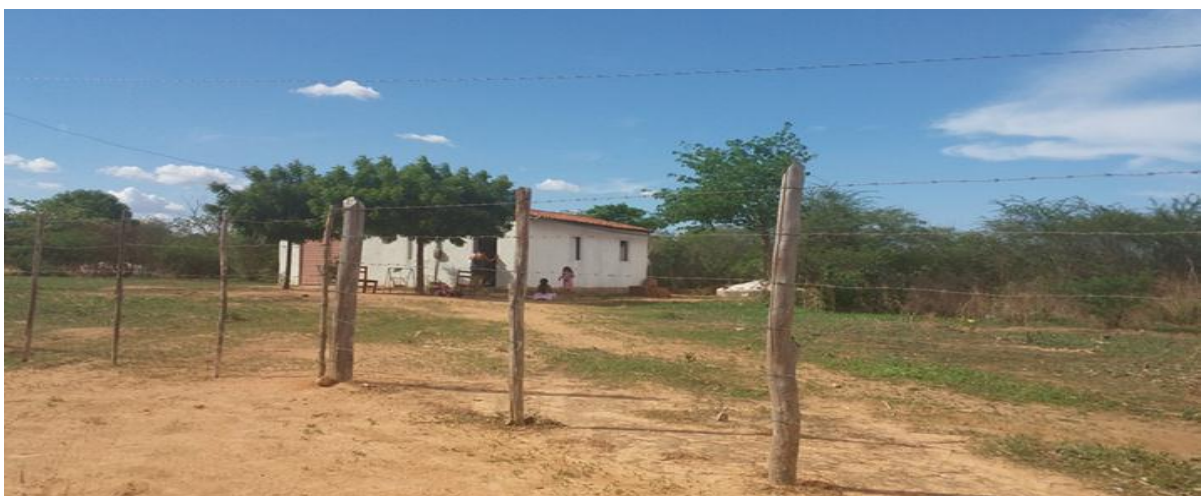
Imagem 12 - Vista frontal de algumas casas do assentamento
