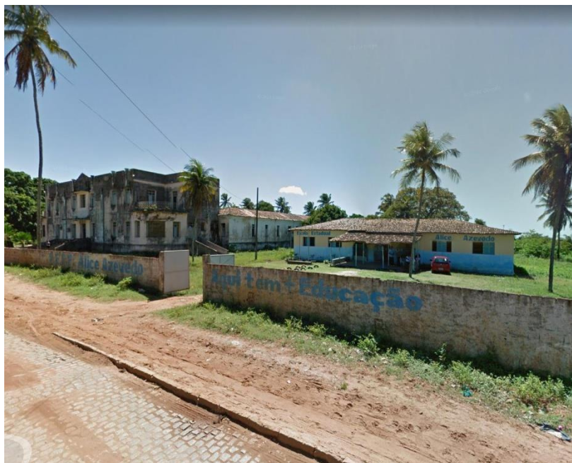
Figura 2 Escola Estadual Alice de Azevedo, erguido ao lado do Preventório. Fonte: Google Street view.
