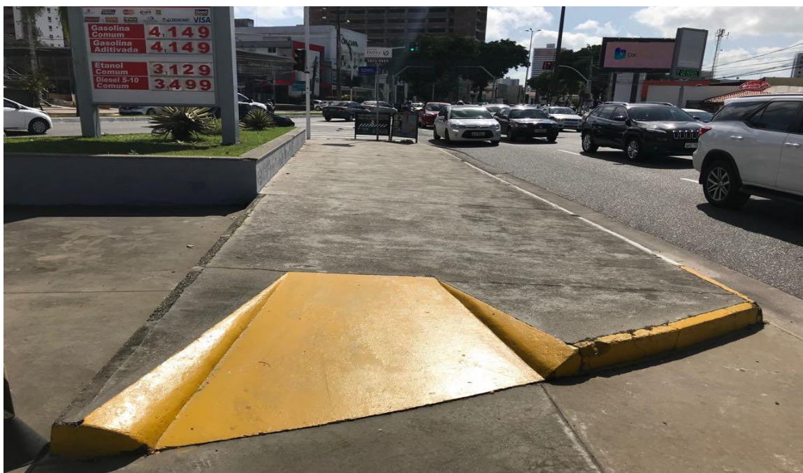
Figura 2. Calçada rebaixada para acesso de pessoas com deficiência, na Av. Ruy Carneiro. Avenida Rui Carneiro. 2018. Foto: Hélder Fernandes.
