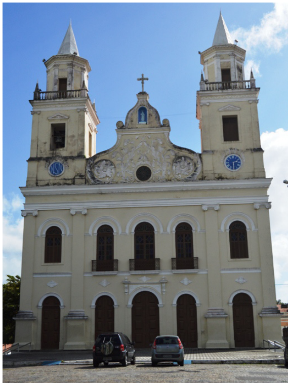
Figura 18: Igreja de N. S a das Neves.
