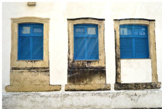
Figura 28: Detalhes da janela - Solar do Conselheiro.
