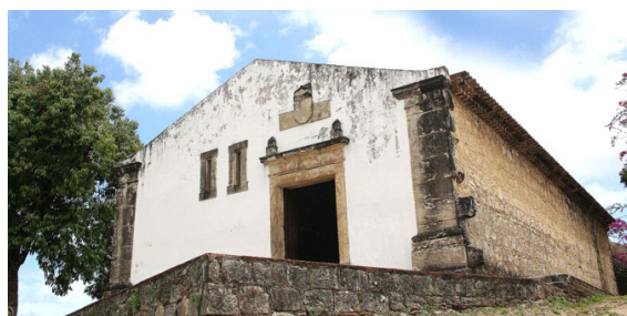
Figura 26: Casa da Pólvora.
