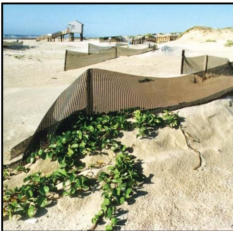
Figura 22. Utilização de cerca para reparar duna danificada. Extraído de Texas General Land Office, (2005).
