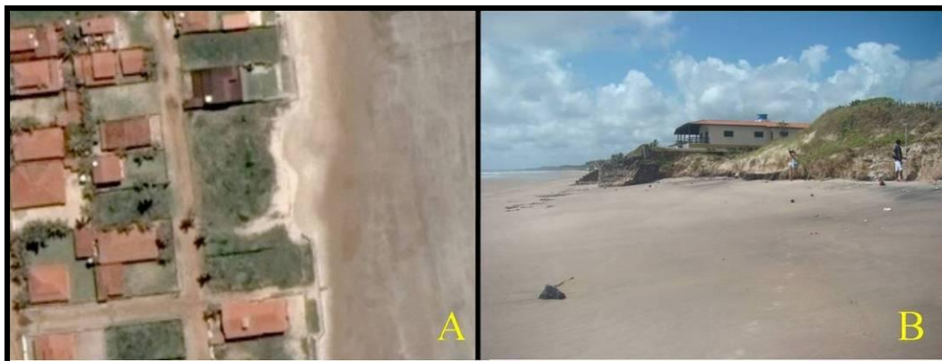
Figura 45. A e B representam o mesmo local sendo respectivamente, imagem aérea de erosão em um lote não construído (extraído de Bing Maps), e fotografia de erosão em lote não construído.
