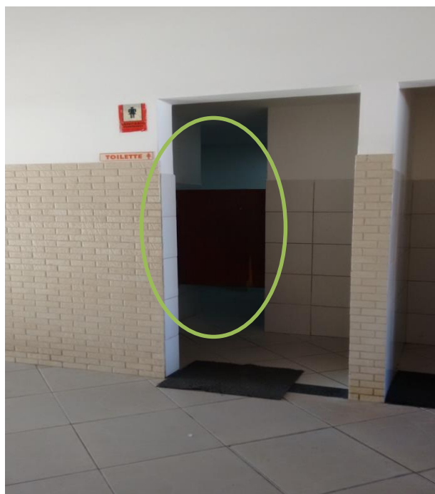
Figura 14: Banheiro do estabelecimento
