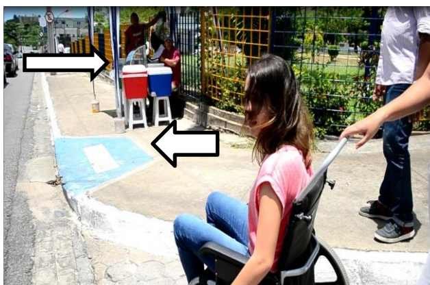
Figura 8: Barreiras na rampa de acesso
