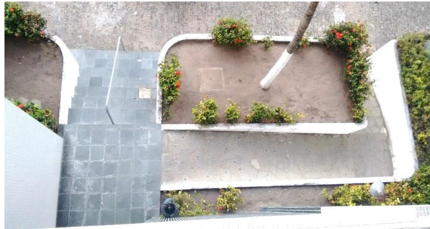
Figura 3: Garagem do prédio com rampa de acesso
