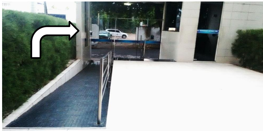
Figura 2: Entrada do prédio residencial com rampa de acesso
