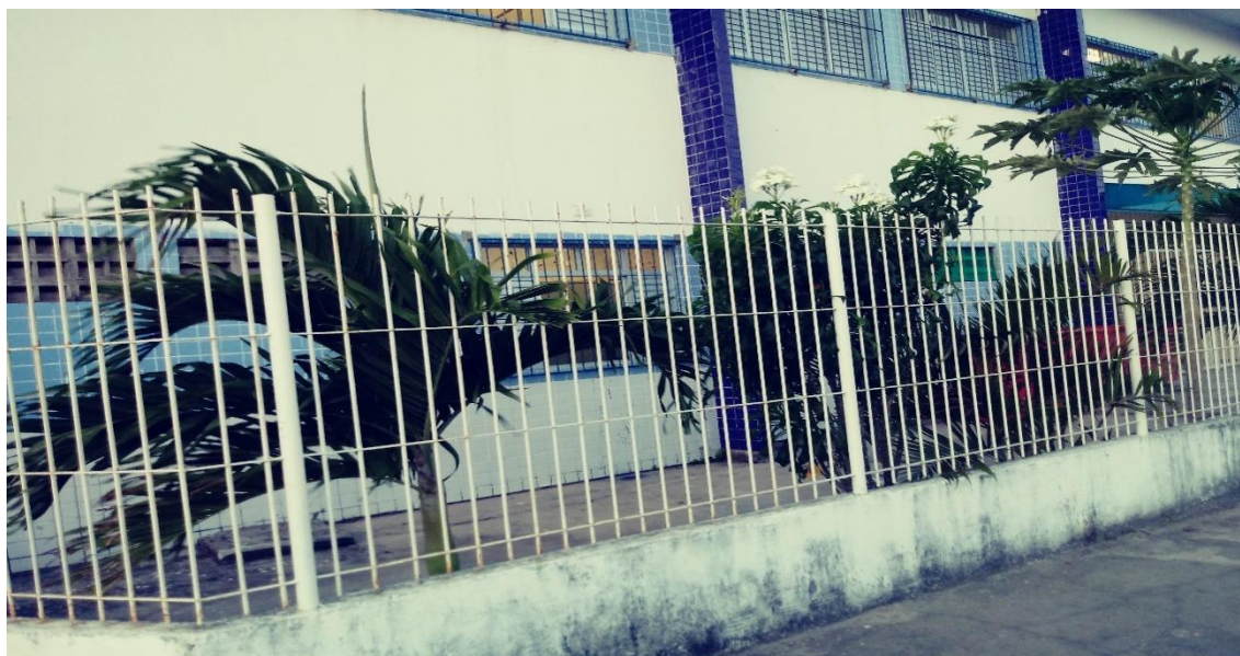
Foto 01 - Jardim e fachada lateral da escola, acesso à rua São Sebastião.
