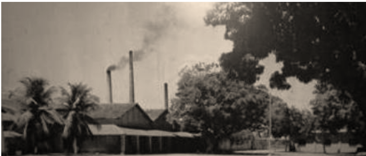
Figura 3: Companhia de Tecidos de Rio Tinto. Vista da lateral do complexo, inaugurado em 27 de dezembro de 1924.
