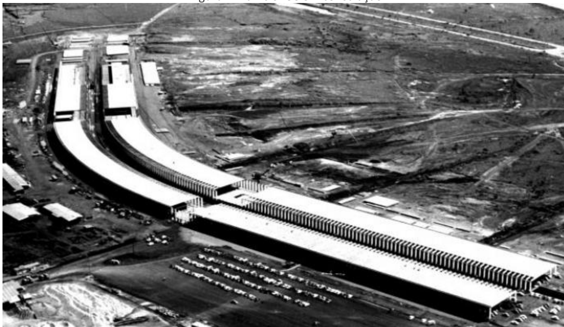
Figura 7: Edifício ICC em construção
