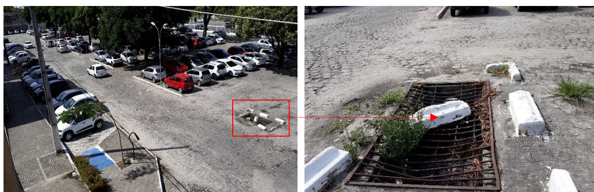
Figura 51 – Estacionamento do Centro de tecnologia e detalhe da drenagem existente
