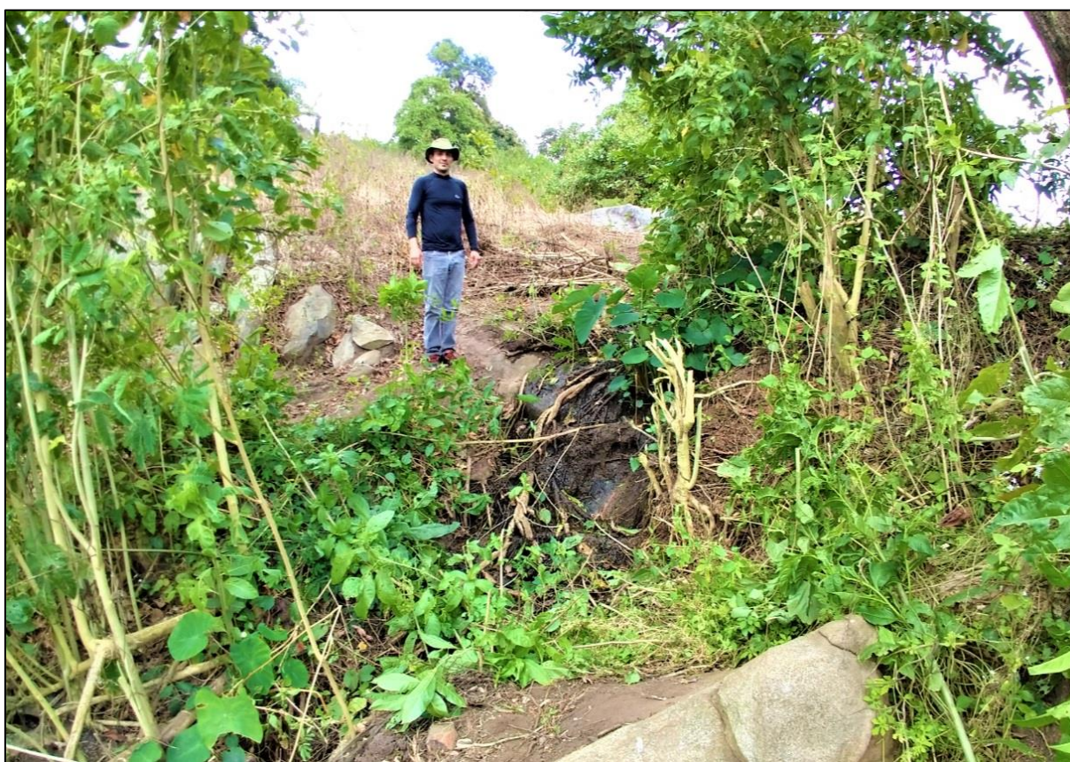
Figura 48 – Desnível altimétrico de aproximadamente 2 metros afetando canal de riacho de 1ª ordem nas proximidades da cidade de Serra da Raiz-PB. Foto: Ivanildo C. Silva (2018).
