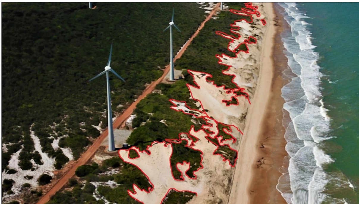
Figura 121 – Avanço da dissecação sobre as dunas inativas com diminuição da vegetação (linhas vermelhas) e evidências de atuação das marés no processo erosivo da base desses sedimentos. Foto: Ivanildo C. Silva (2019).
