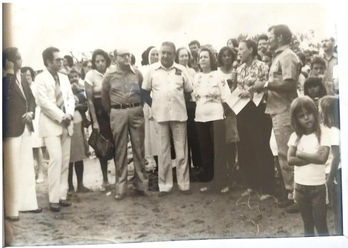
Imagem 40 – Aposição da pedra fundamental para a construção da sede-escola das Ex-alunas Dorotéia. (1953)
