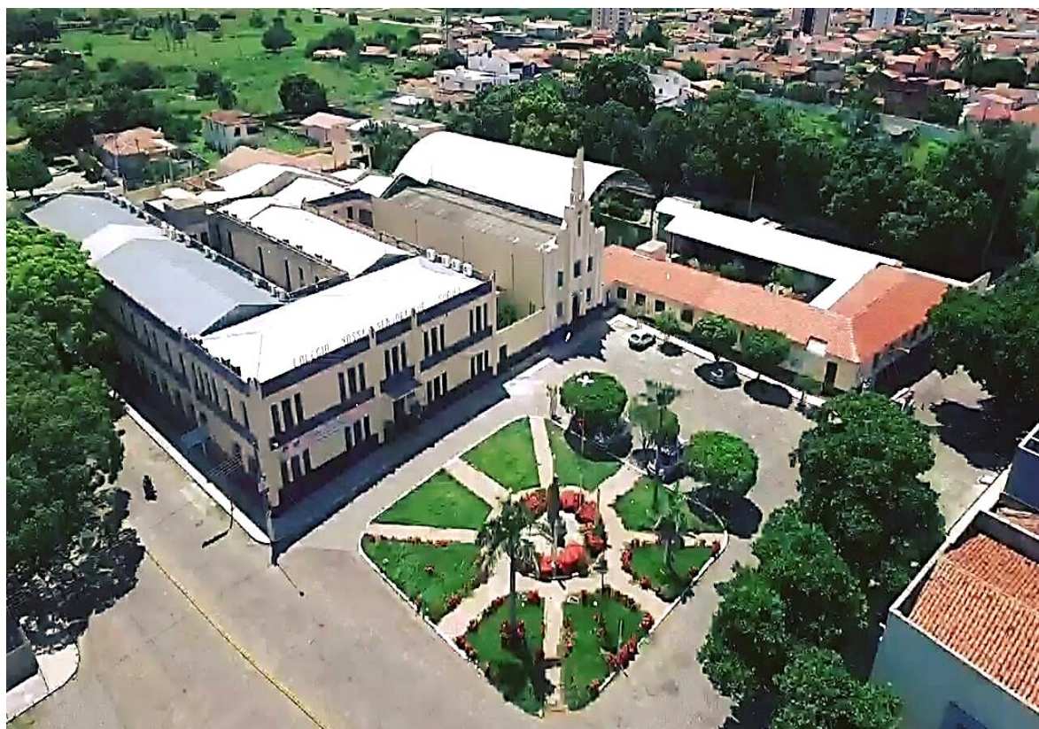
Imagem 16 – Foto aérea do Colégio Nossa Senhora de Lourdes.
