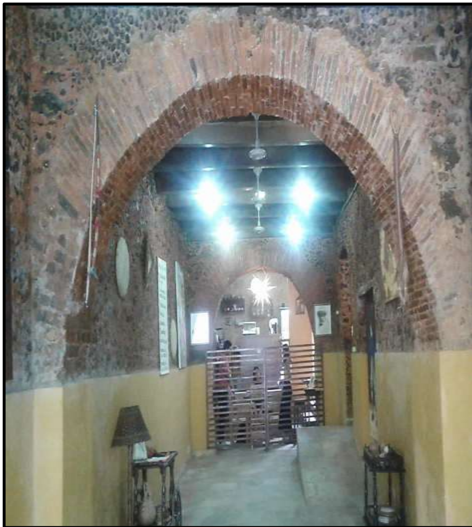
Fig.45 – Imóvel no beco Catarina Mina/Centro Histórico de São Luís construído com a técnica de pedra e cal.
