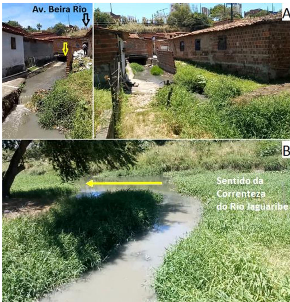
Figura 3.7. Galeria de esgoto oriundo do bairro Miramar, João Pessoa, PB (A) passando por baixo das residências da comunidade Tito Silva, indicada pela seta amarela (B) esgoto proveniente da galeria indicada, sendo lançada diretamente no rio Jaguaribe, registrado em setembro de 2019, antes da instalação dos módulos de Biorremediação.
