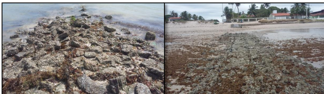
Figura 5. "Gabiões" utilizados para reduzir a dinâmica de sedimentos na zona entre-marés na faixa de areia, localizados na Praia Formosa, Cabedelo-PB.
