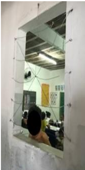
IMAGEM 19- Sala sem Janela.
