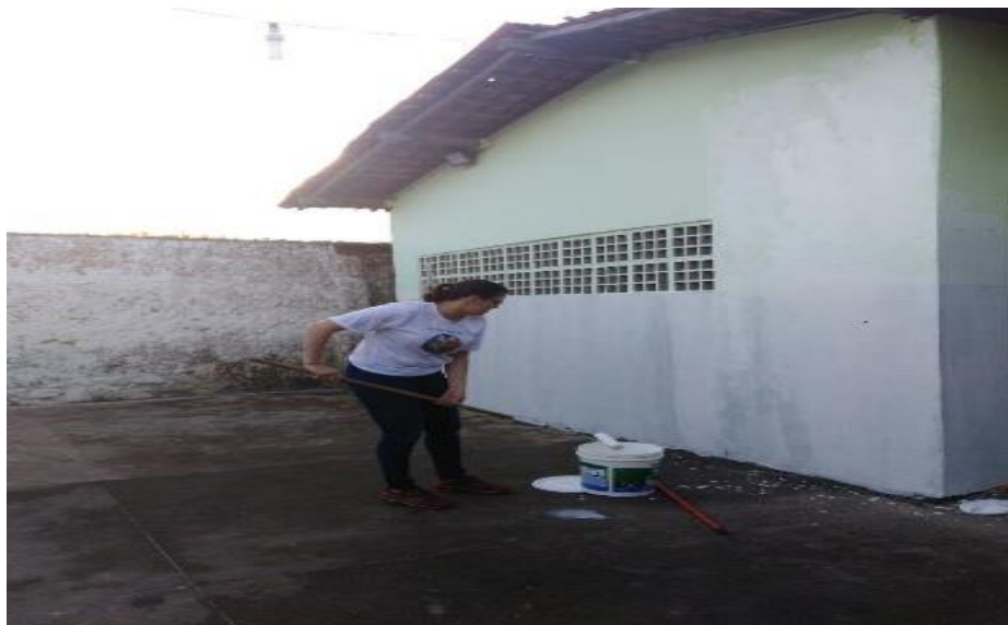
IMAGEM 31 – Sala sendo pintada
