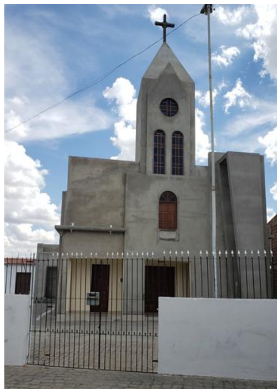
Igreja Católica (em construção)
