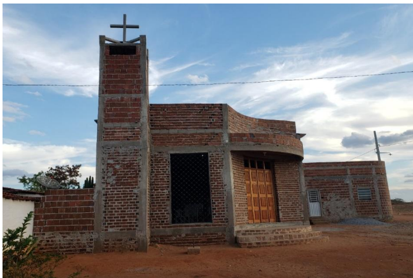
Igreja Católica (em construção)
