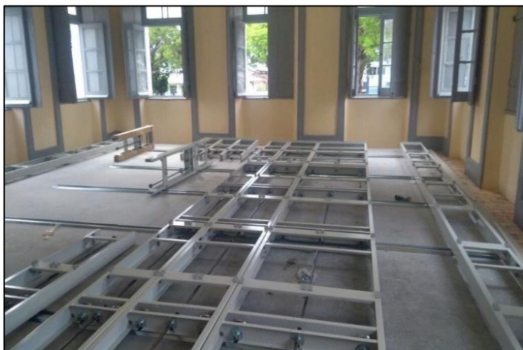
Imagem 7 - Instalação das estantes deslizantes
