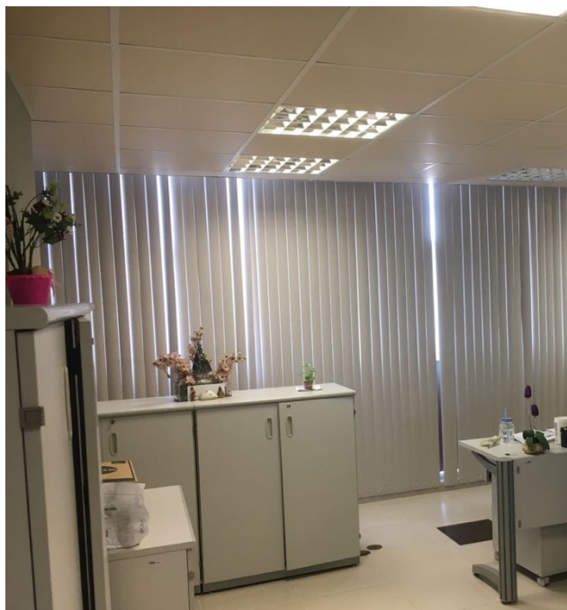
Figura 37: Vista do forro modular e luminárias padrão.
