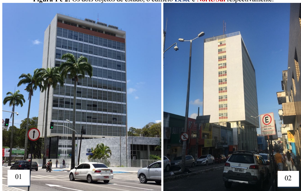
Figura 1 e 2: Os dois objetos de estudo, o edifício Leste e Norte/Sul respectivamente.
