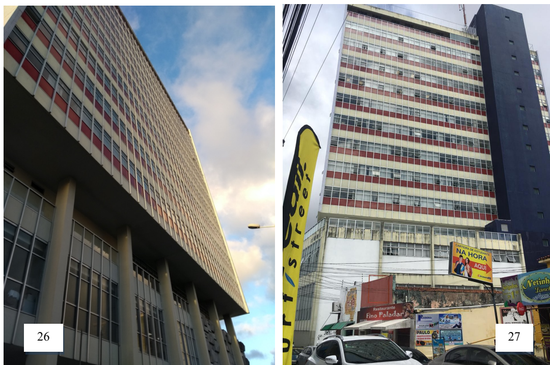
Figura 26 e 27: Edifício Norte/Sul. Vista fachada Sul e Norte, respectivamente.
