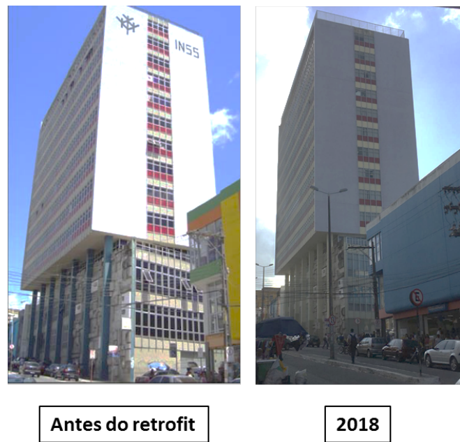
Figura 32: O edifício antes do retrofit e em 2018.
