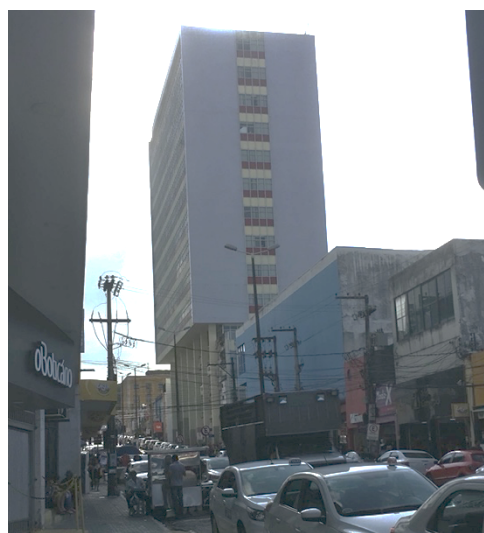
Figura 8: Vista do edf. Norte/Sul a partir da Rua Barão do Abiaui.
