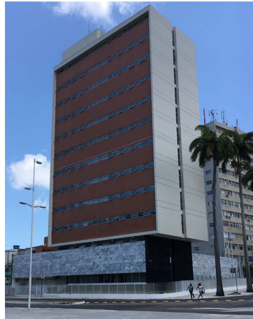
Figura 10: Vista das fachadas Oeste e Sul.
