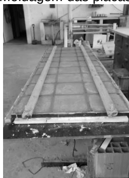
Figura 30 – Moldagem das placas de concreto
