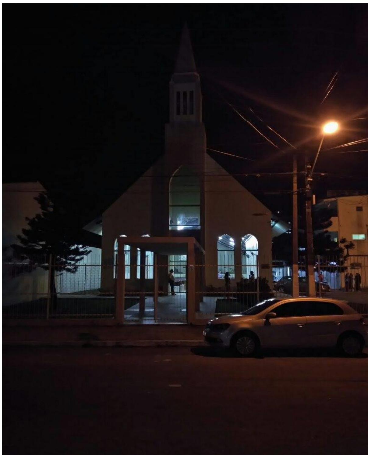
Fachada da igreja (Fonte: Arquivo Pessoal)
