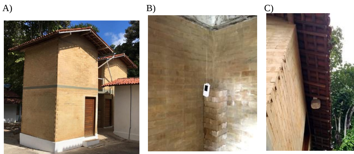
Figura 12 - Protótipos com paredes de BTC. A) Vista do posicionamento dos protótipos (1), na frente; (2) ao fundo; B) Localização interna do Datalogger; C) Proteção externa para Datalogger, localizado no beiral (Fonte: Autor, 2019).
