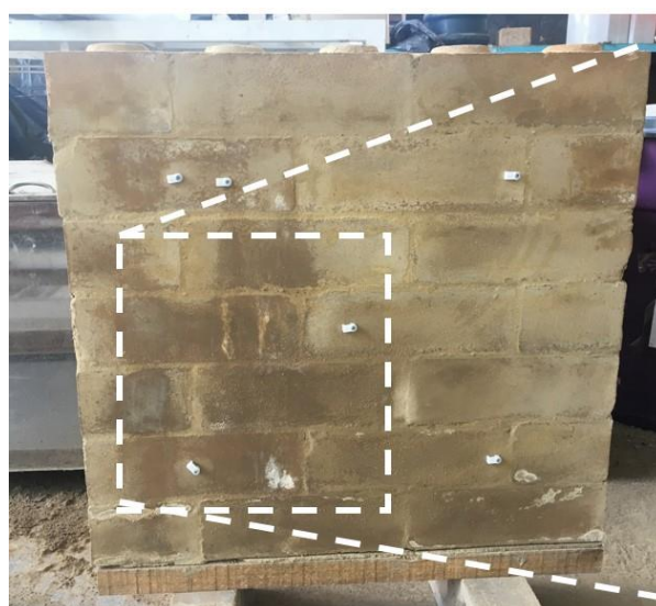
Figura 30 – Pequena parede TC – Tratamento Controle. A) Antes do ensaio; B) Após o ensaio; Imagens com detalhes ampliados no lado direito.
