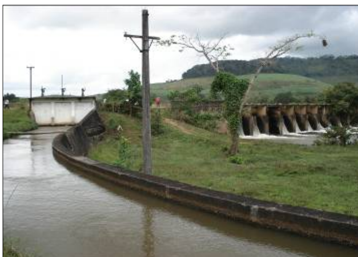
Fotografia da Hidroelétrica da Usina Catende 2007 Fonte: Acervo de pesquisa (foto 1006, Out/2007)
