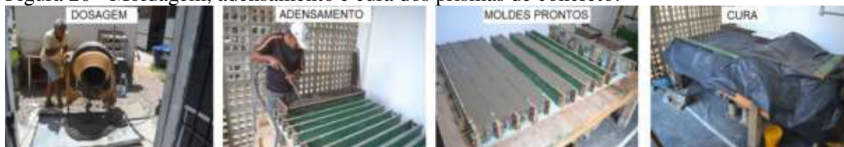
Figura 20 - Moldagem, adensamento e cura dos prismas de concreto.
