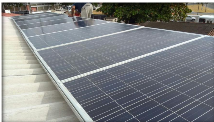
Figura 40 - Módulos instalados no telhado.
