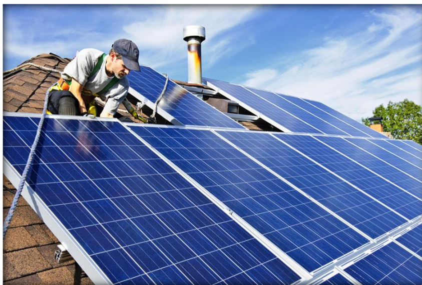
Figura 15 - Painel fotovoltaico sendo montado
