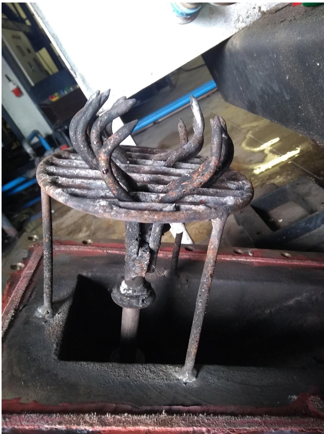
Figura 4.5: Sistema de desobstrução
