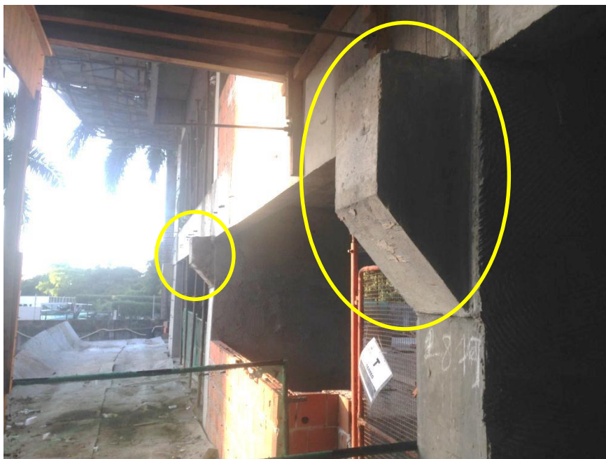
Figura 40 - Consoles dos pilares executados no pavimento térreo
