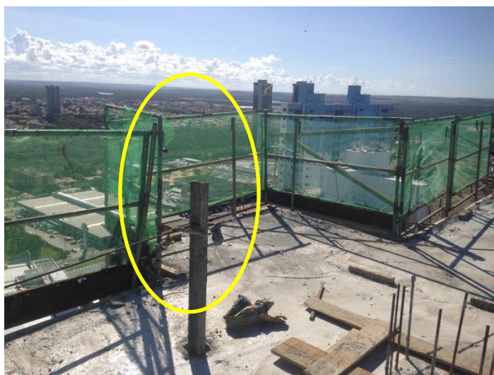
Figura 48 - Parte superior do perfil onde é colocado o cabo de aço
