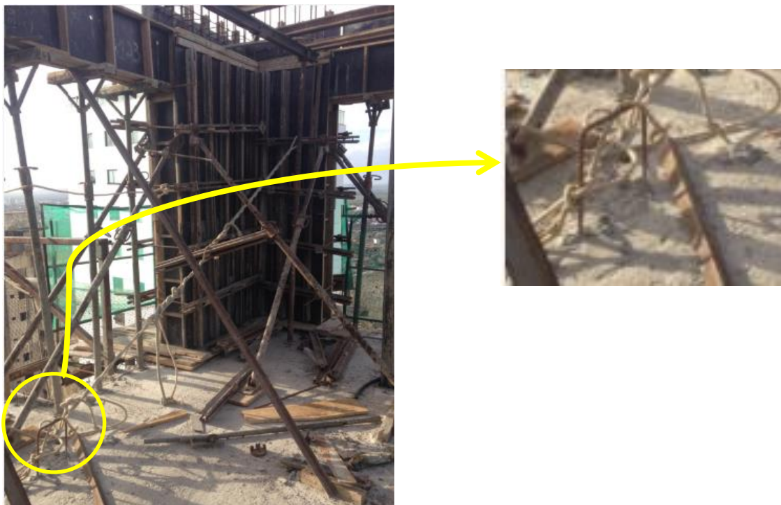
Figura 46 - Reforço com cordas utilizado no Pilar em L
