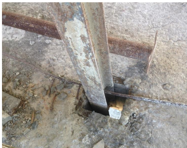
Figura 49 - Dispositivo de travamento do perfil
