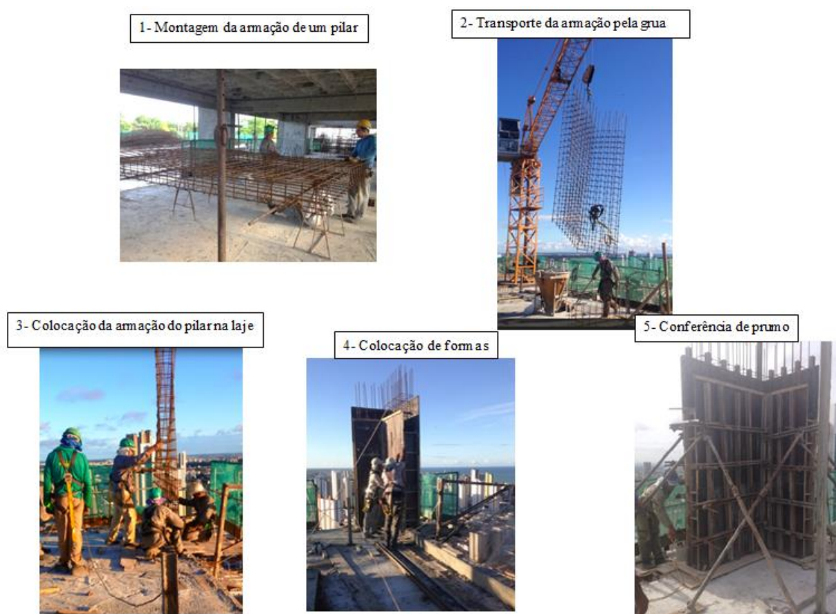
Figura 45 - Sequência da atividade de execução de armação e forma de pilares
