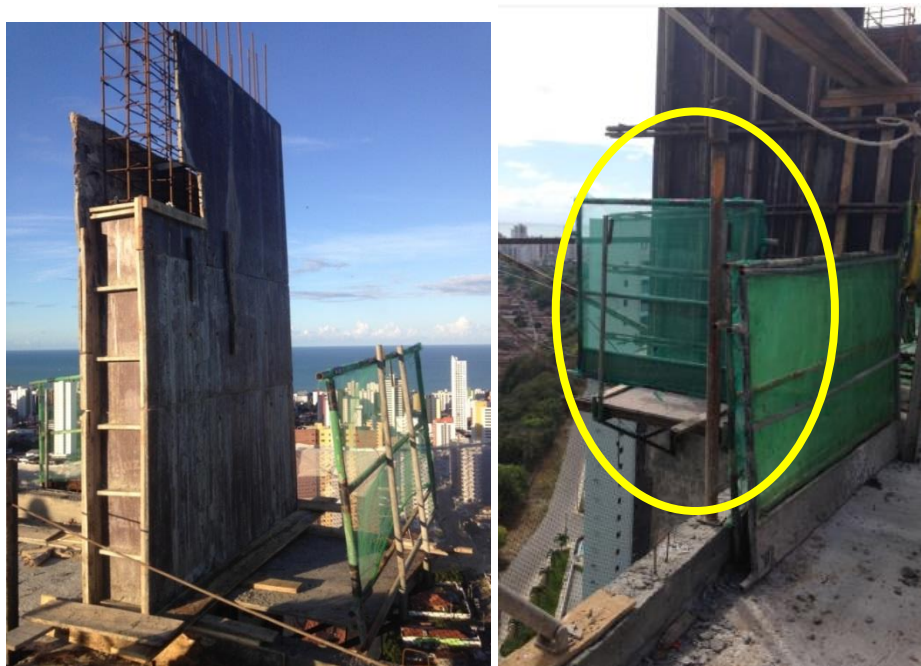
Figura 53 - Plataforma depois da colocação da armação e formas
