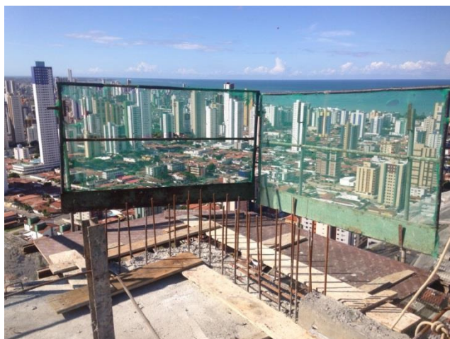
Figura 52 - Plataforma antes da colocação da armadura do pilar
