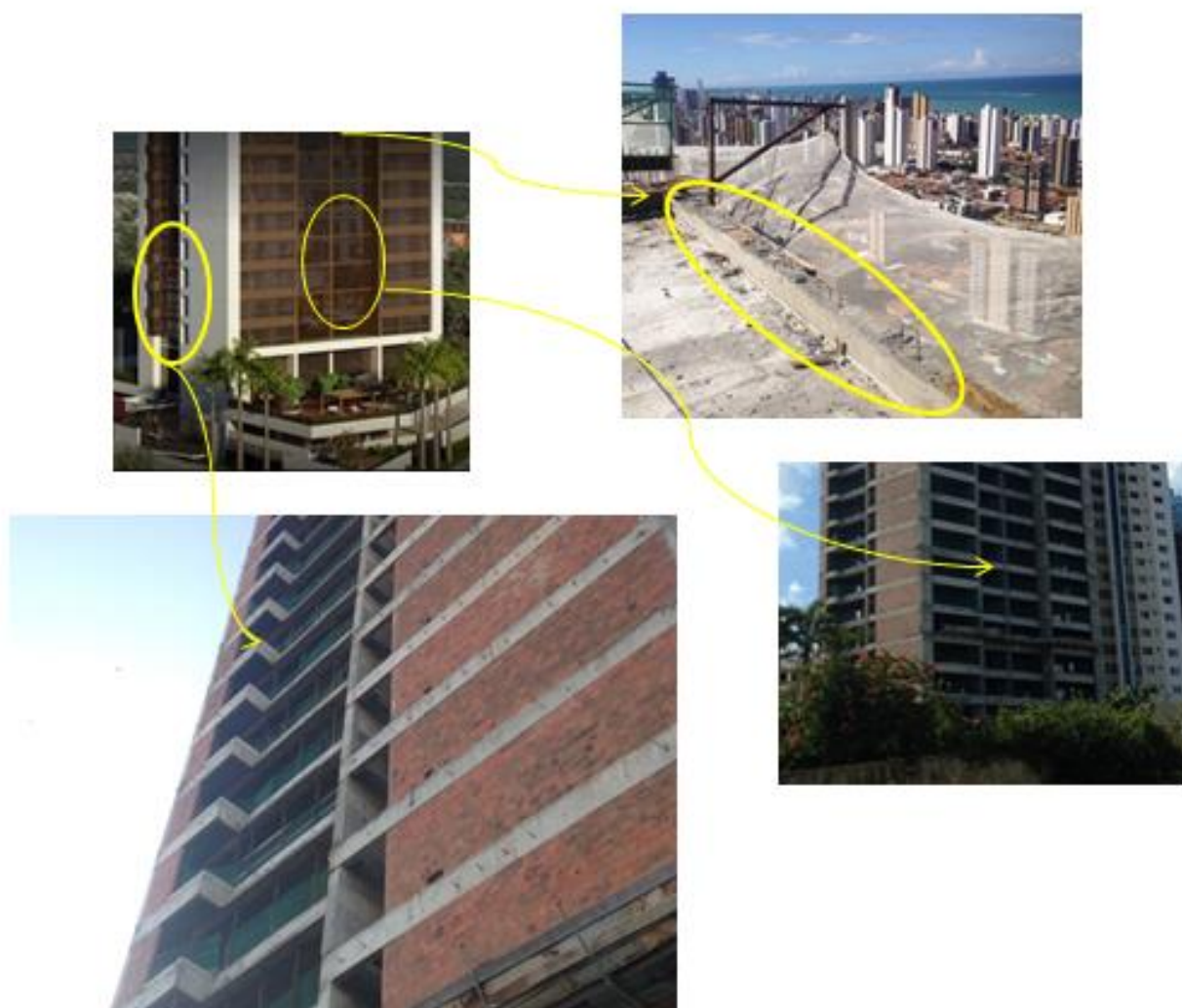
Figura 39 - Detalhe da viga para fixação de vidros na fachada
