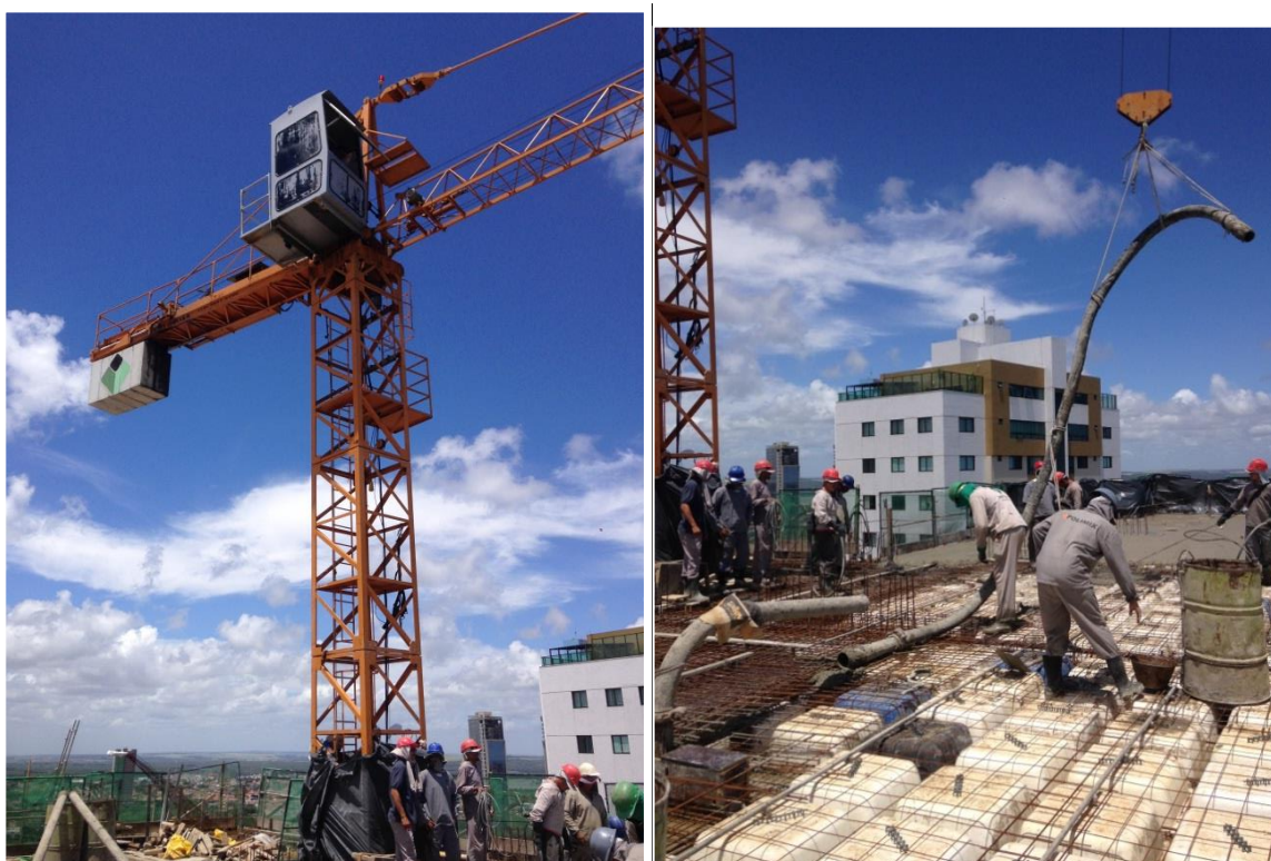
Figura 47 - Utilização da grua para concretagem de lajes
