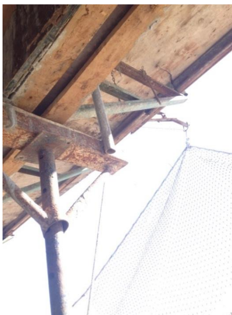
Figura 54 - Vista inferior do sistema de fixação da plataforma
