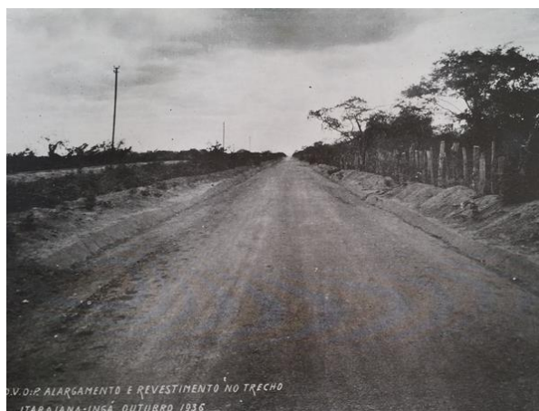
Figura 23: Alargamento e revestimento estrada Itabaiana-Ingá. Fonte: DEPPB (1938)
