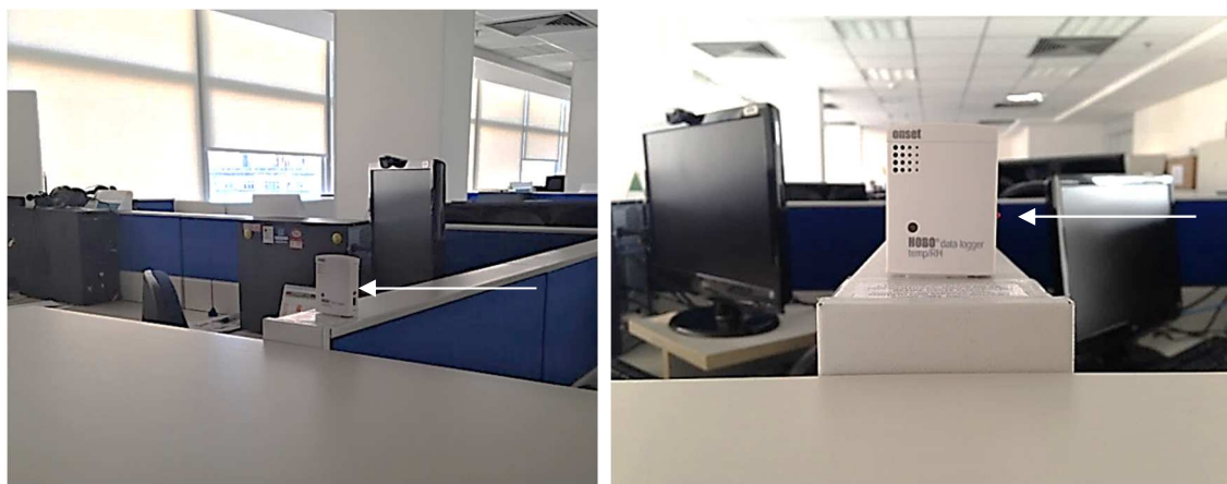
Figura 39 – Instalação dos Dataloggers Hobo
