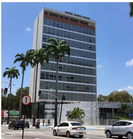
Figura 22 – Fachada Leste após o retrofit .
