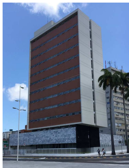
Figura 23 – Fachada Oeste após retrofit .
