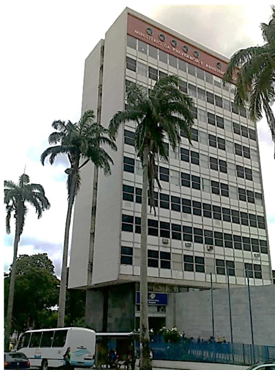
Figura 21 - Fachada leste do edifício em 2013.
