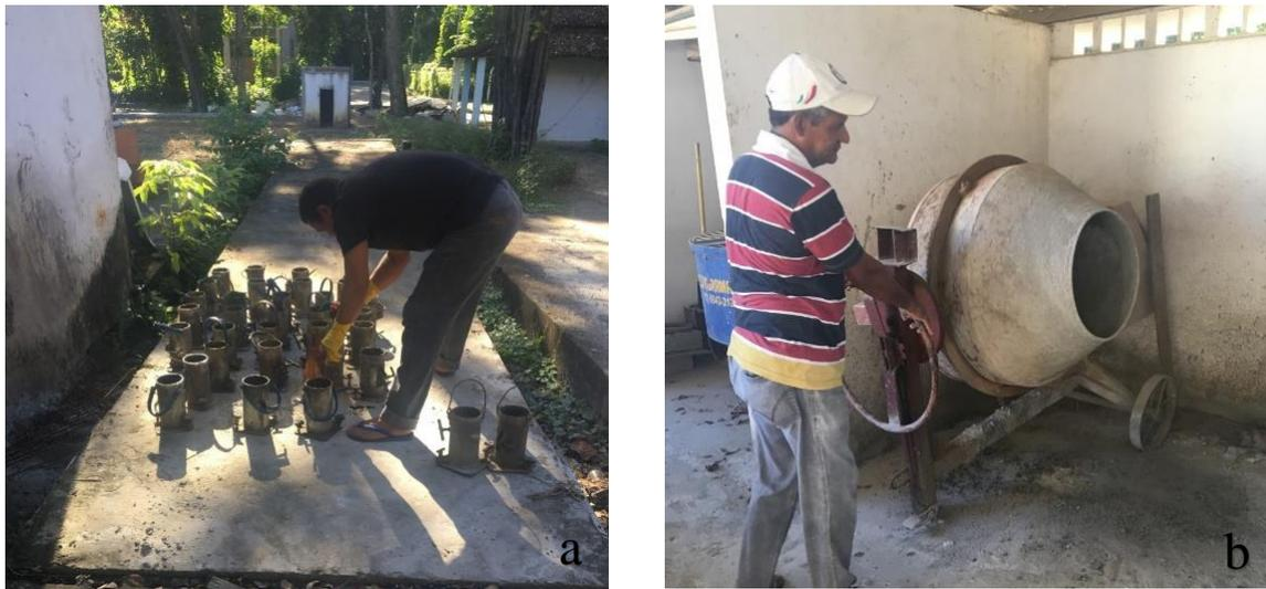
**Figura 6.** (a) Preparação dos moldes untados com óleo mineral; (b) mistura dos agregados secos e do cimento na betoneira.
