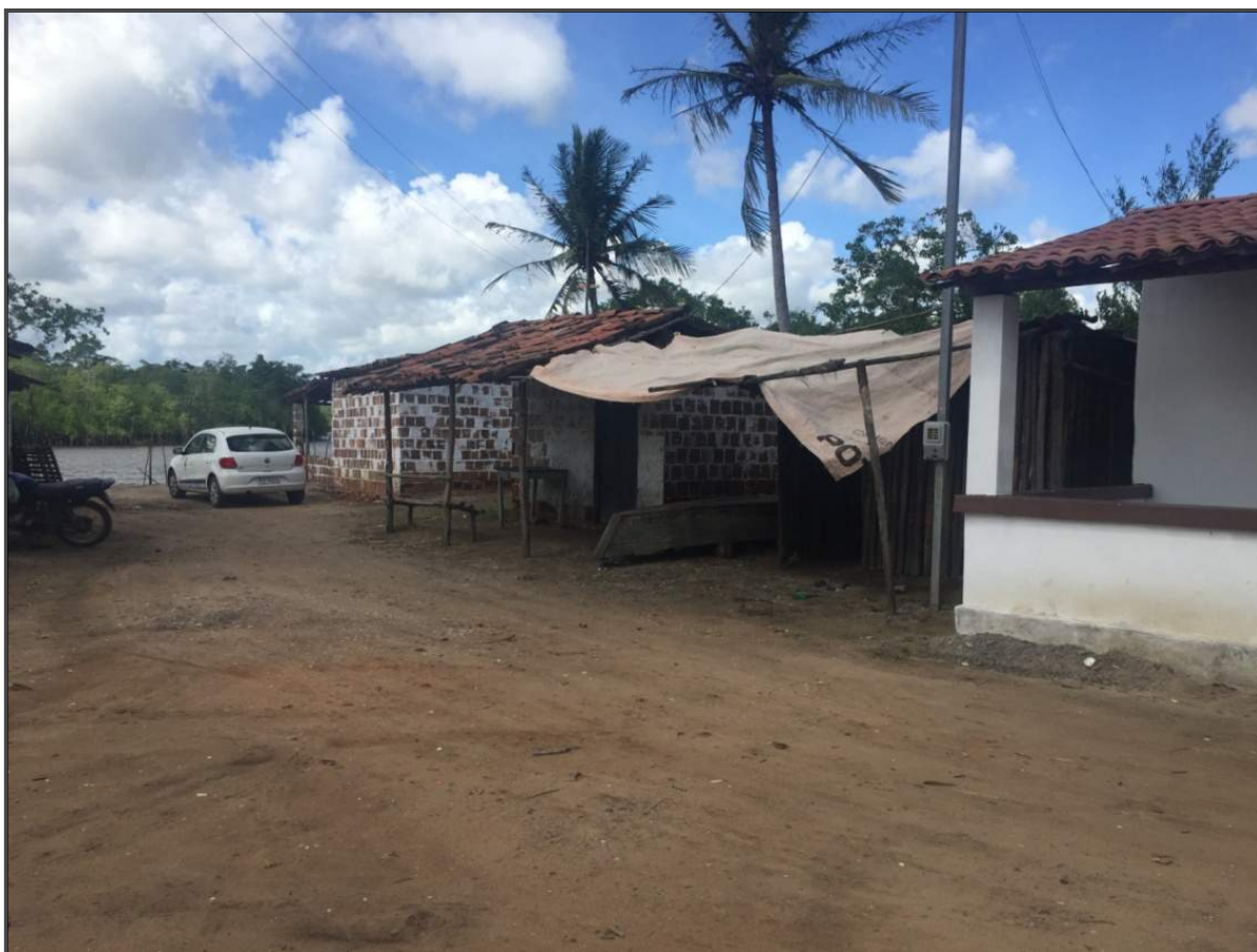
Figura 3 - Casas construídas pelos produtores de Porto Novo para apoio às atividades de ostreicultura
