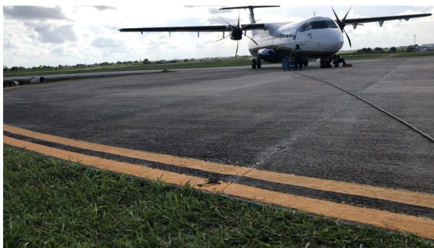
Figura 1.1.b Pátio de taxiamento de aeronaves. Fonte: Autor
