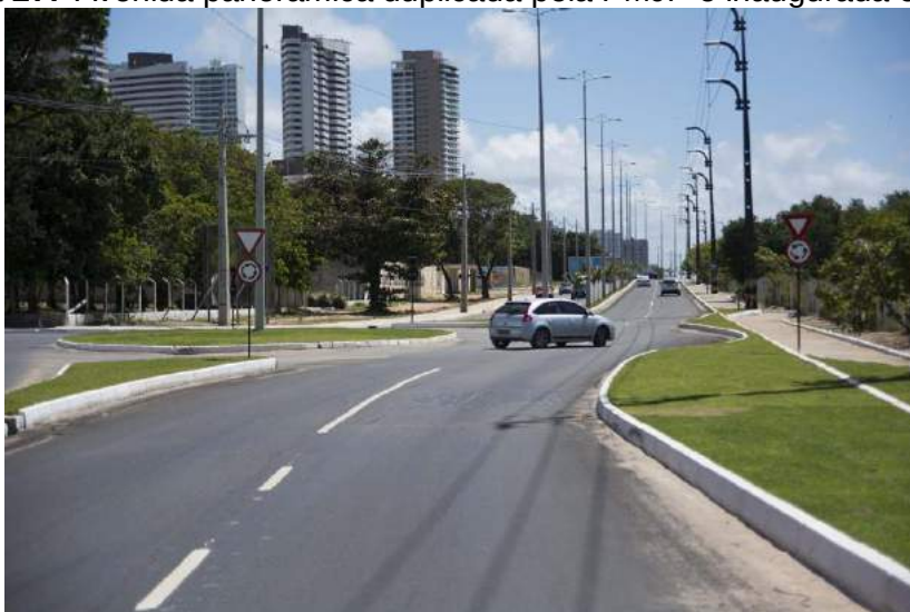
Figura 27: Avenida panorâmica duplicada pela PMJP e inaugurada em 2014
