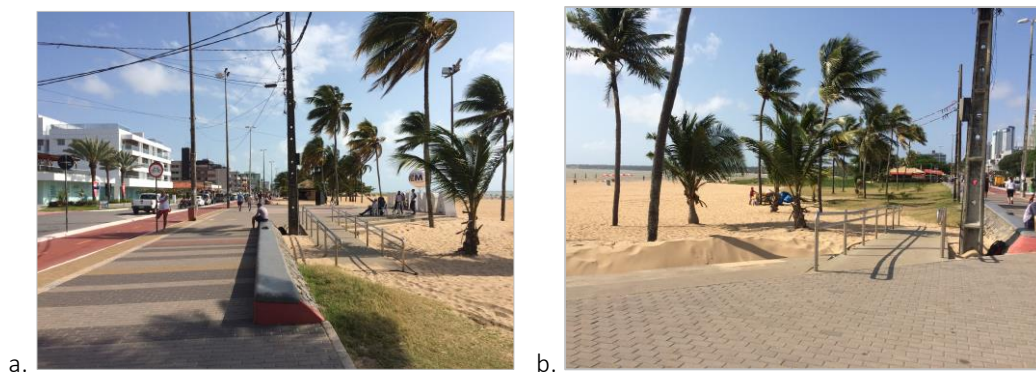
Figura 110 – a), b) Rampa de acessibilidade entre área do busto e areia da praia
