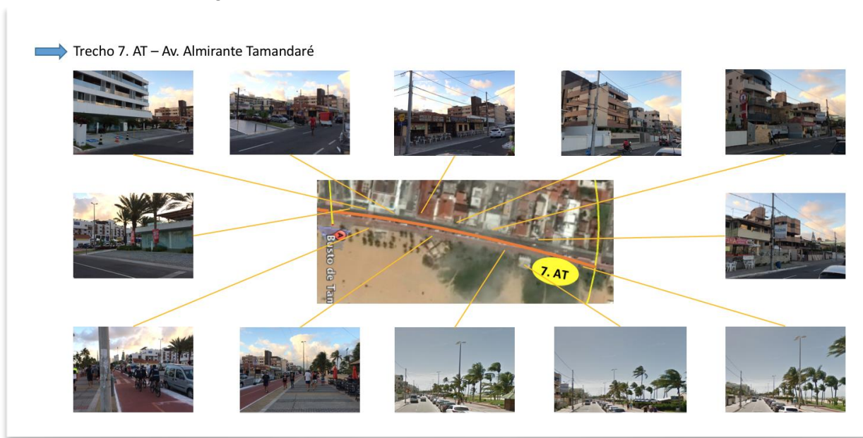
Figura 227 – Trecho estudado da Avenida Almirante Tamandaré
