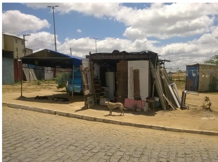
Figura 10: Construções precárias localizadas no bairro Três Irmãs
