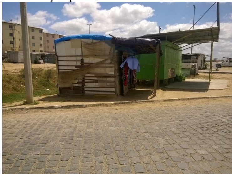
Figura 11: Construções precárias localizadas no bairro Três Irmãs
